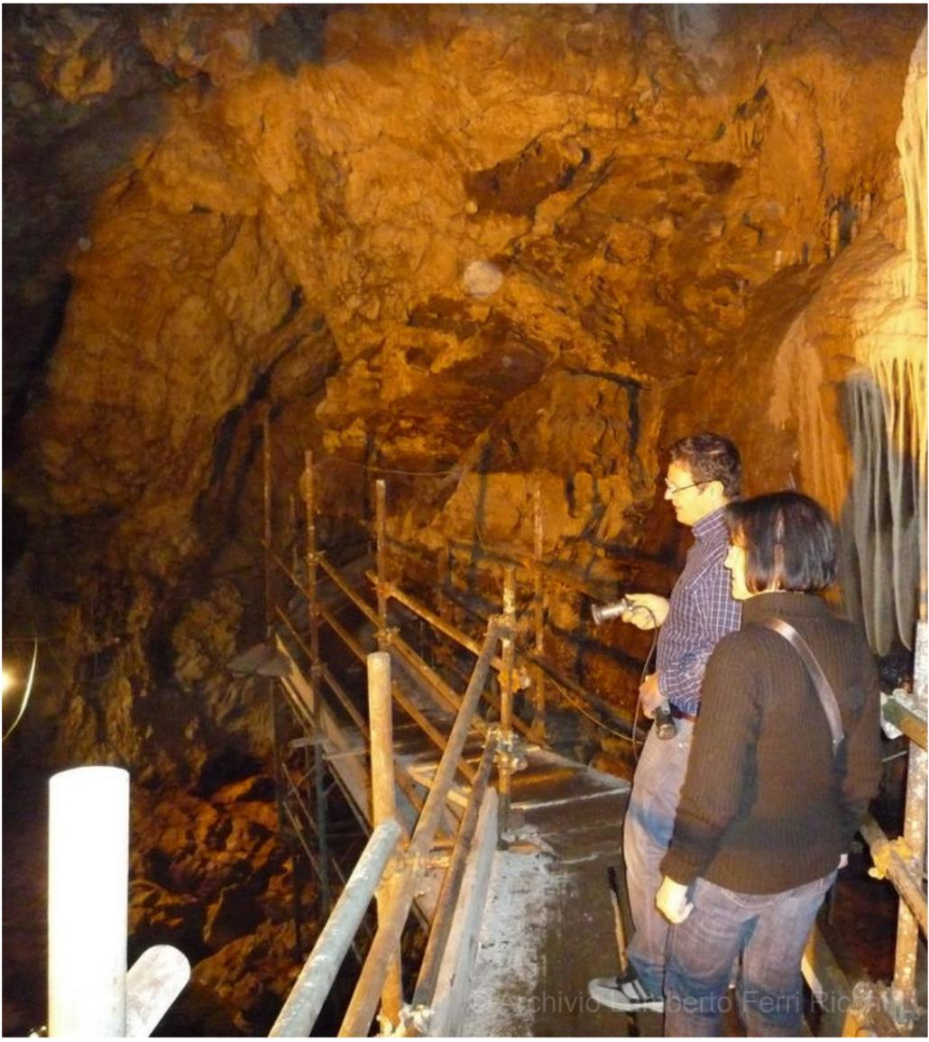
Le foto mostrano le passerelle in fase di costruzione. Ogni accorgimento è stato messo in atto per consentire un'agevole visita anche ai turisti disabili quali: passerelle spaziose per consentire la sosta, l'abolizione dei gradini e la pendenza del pavimento dei percorsi quasi ovunque contenuta entro valori minimi.
