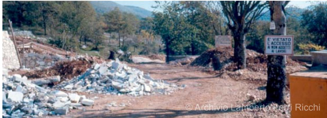
*Foto a lato: l'asfaltatura del piazzale di sosta che ha impermeabilizzato una vasta superficie soprastante le Grotte alterando le condizioni chimico-fisiche che regolano la formazione degli speleotemi. Le conseguenze più appariscenti sono il prosciugamento delle stalattiti nel salone d'ingressoso.*
