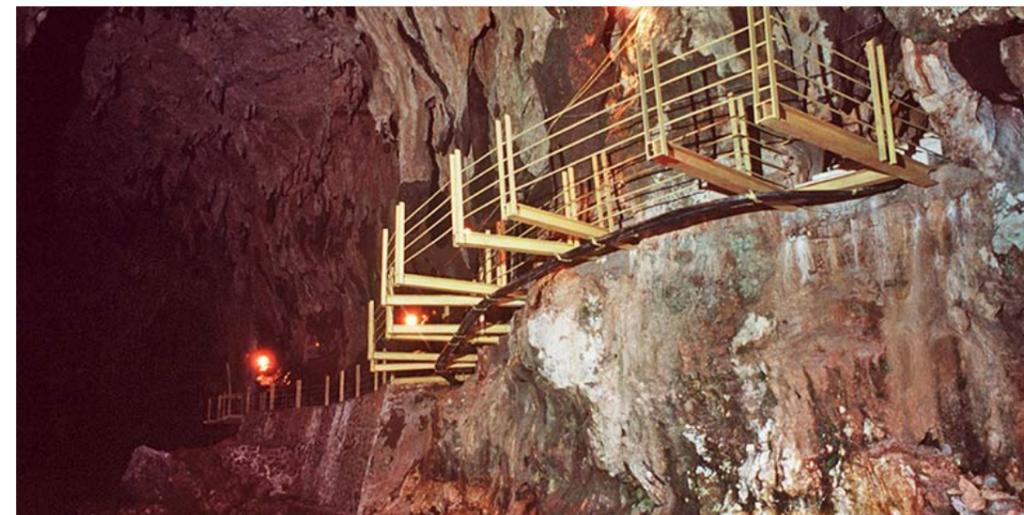
La snella passerella all'ingresso delle Grotte in fase di costruzione. Le travi di ferro, danneggiate da una trentennale incuria, sono state di recente rinforzate con deturpanti puntoni di ferro.
