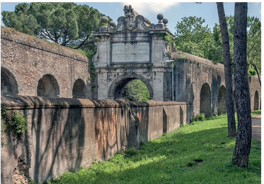
In alto: le numerose arcate dell'acquedotto Traiano costruite per superare un profondo fossato nei pressi di Santa Maria di Galeria (foto Google Earth).
