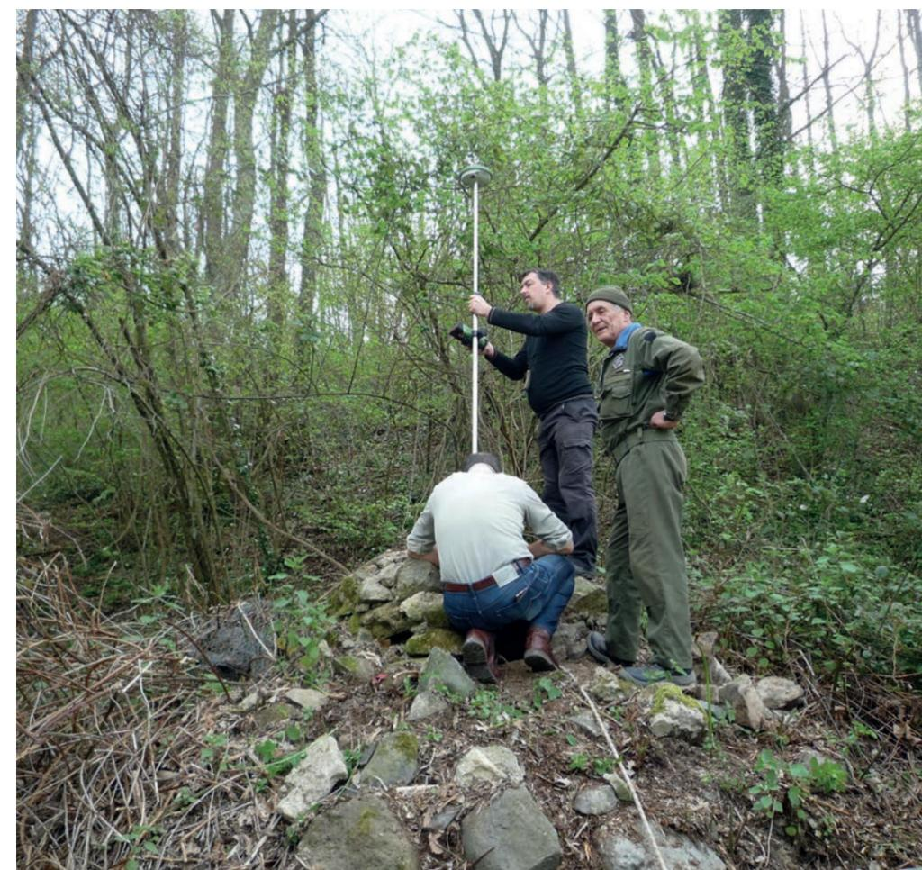
A fianco: la posizione dei pozzi fu rilevata con strumenti topografici satellitari. Un tecnico controlla lo strumento per la ricezione dei segnali.
